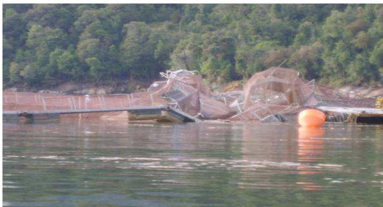
Figura 14 - Balsas jaulas metálicas destruidas tras un temporal, Navtec 2011
