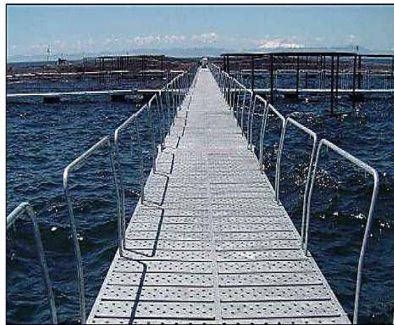
Figura 6 - Pasillo central de balsas jaulas metálicas cuadradas, Navtec 2011
