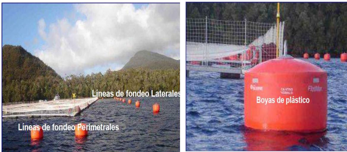
Figura 10 - Líneas de fondeo con boyas de plástico de balsas jaulas metálicas cuadradas
