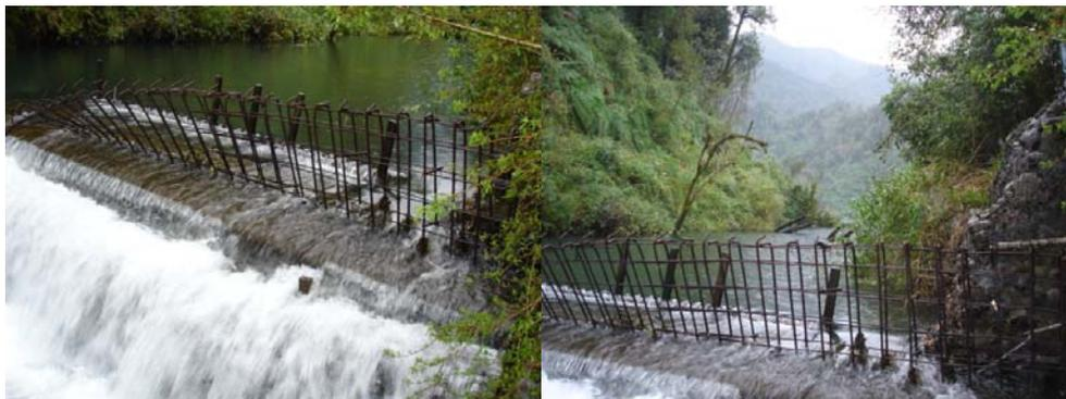
**Figura 29. Diques de contención en mal estado en el desagüe de Laguna La Pata**
