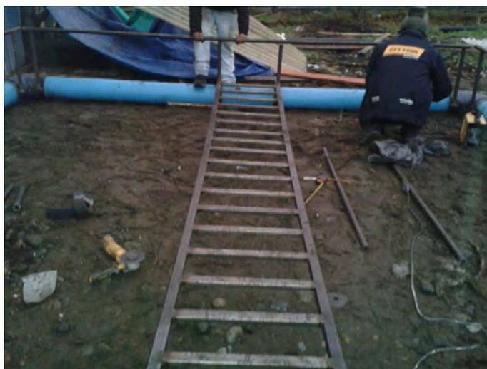
Figura 4.73: Construcción de plataforma de mantenimiento para ejemplares vivos.
