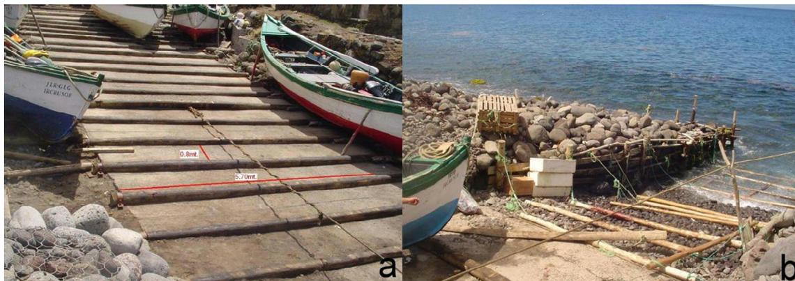
Figura 11: Rampa de la caleta (a) primer tramo construido de hormigón y rollizos en superficie (b) segundo tramo construido de rollizos y grava.
